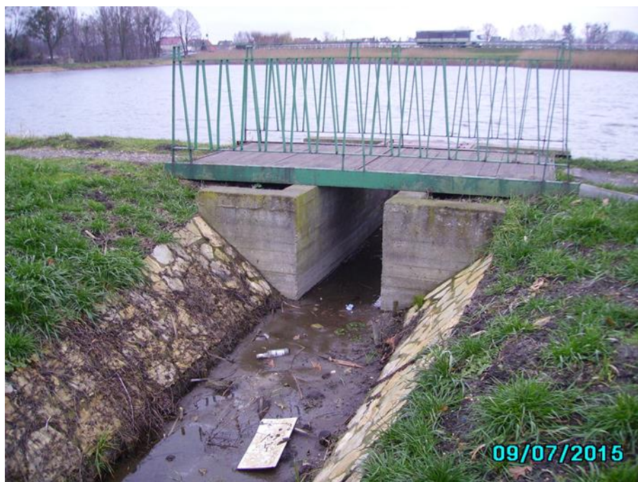
Kładka piesza M-2 na zbiorniku „Dewizowiec” - do wymiany
