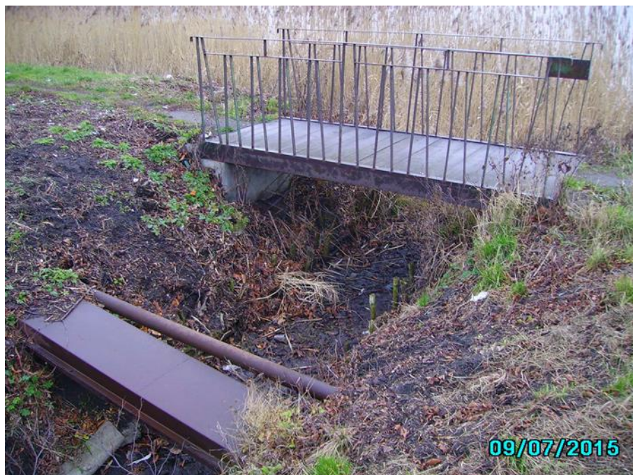
Kładka piesza M-1 na rowie RA na dopływie do zbiornika „Dewizowiec” - do wymiany
